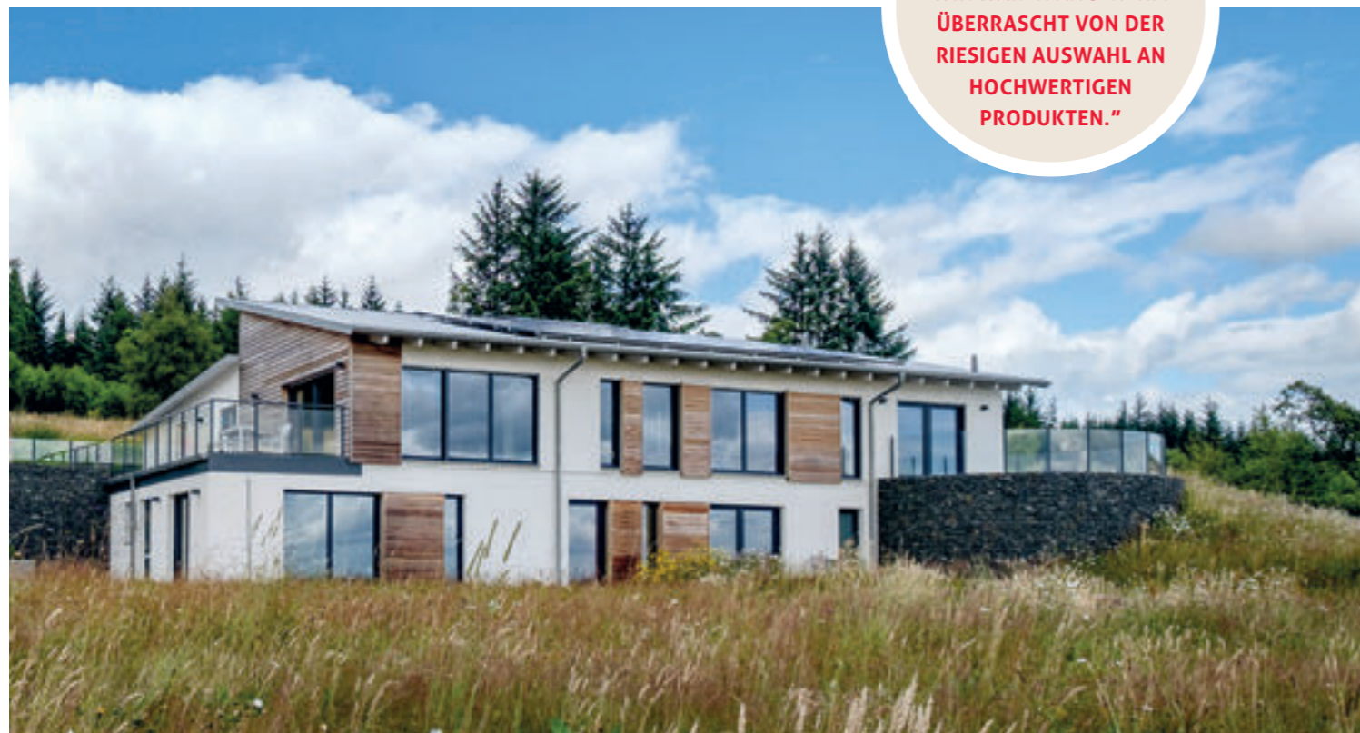
Clever geplant Die Bauherren haben ihr Traumhaus gemeinsam mit Hanse Haus ganz individuell an ihre Vorstellungen und das Baugrundstück angepasst.
